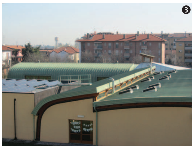
3. Copertura con impianto fotovoltaico – Roof with photovoltaic system
